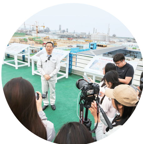
联泓新材料公司推进新能源和生物降解材料一体化项目,总投资215亿元,分三期建设。
