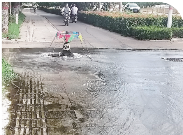
7月22日,新城祁连山路一窨井持续向外溢水。(记者 张莉萍 摄)
