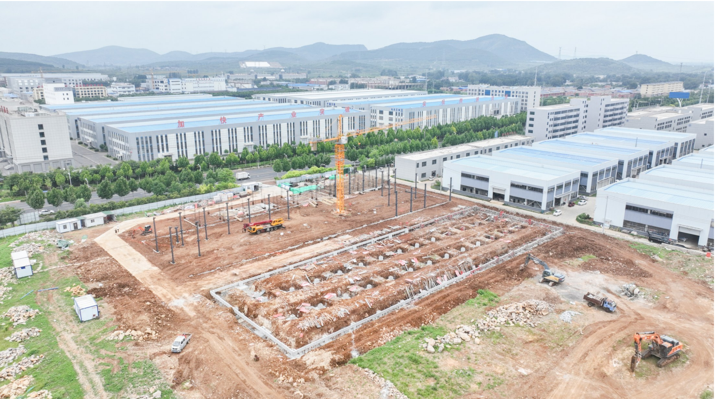
嘉富显示二期项目施工现场
