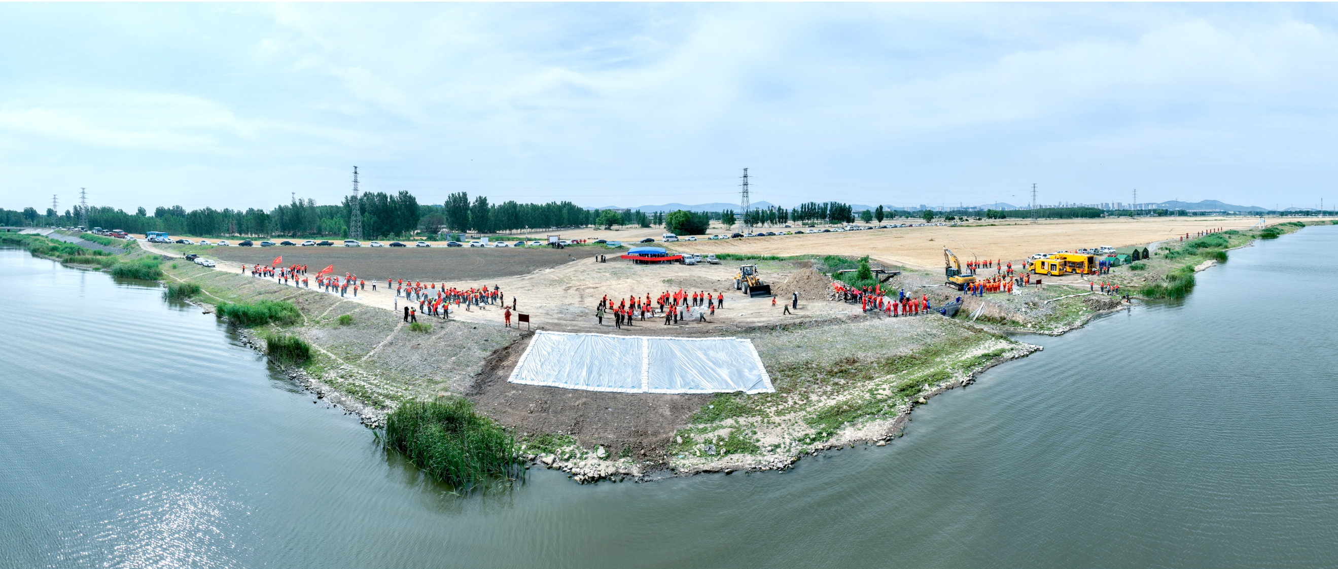
防汛抢险拉练现场
