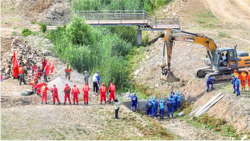
人员配合挖掘机进行抢险工作
