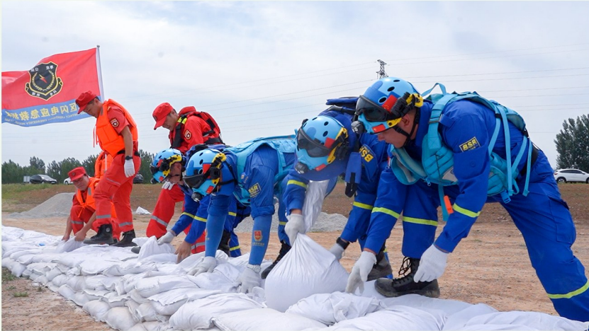
抢险队员正在搬运沙袋
