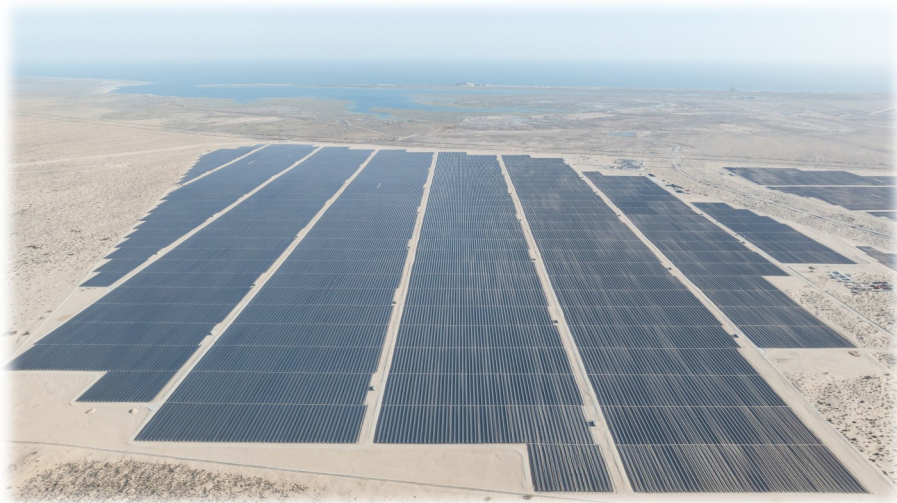
这是2025年4月2日在墨西哥佩尼亚斯科港附近拍摄的中国能源建设集团承建的佩尼亚斯科港光伏项目二期工程（无人机照片）。
