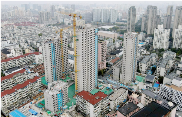
2024年3月15日拍摄的上海市静安区谈家桥城市更新项目建筑工地（无人机照片）。 （新华社记者 方喆 摄）
