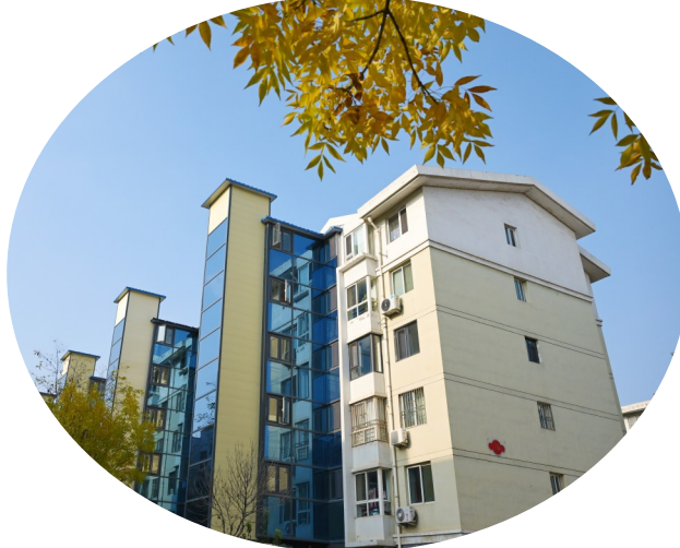
2024年10月31日拍摄的正在加装电梯的银川市兴庆区燕和园小区。新华社发（袁宏彦 摄）
