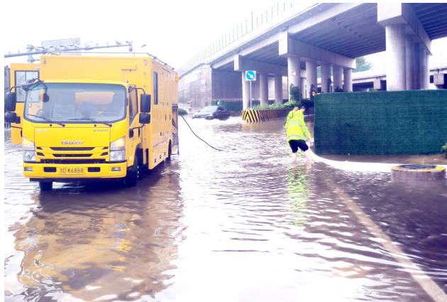
高新区抽调应急排涝救援车在泰山北路进行抽排水作业 （刘豹 李志超 摄）
