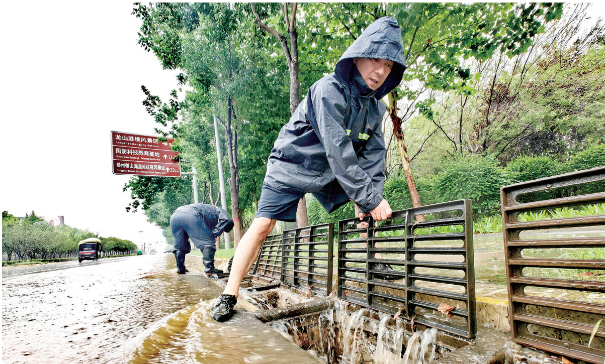
滕州市水务发展集团中润供水公司的工作人员在红荷路进行排水作业 （曹昌宇 摄）
