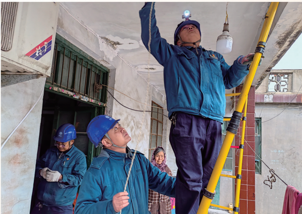
3月5日，市中供电中心西王庄供电所志愿者为民主村独居老人改造家中供电线路。（姜倩 摄）
