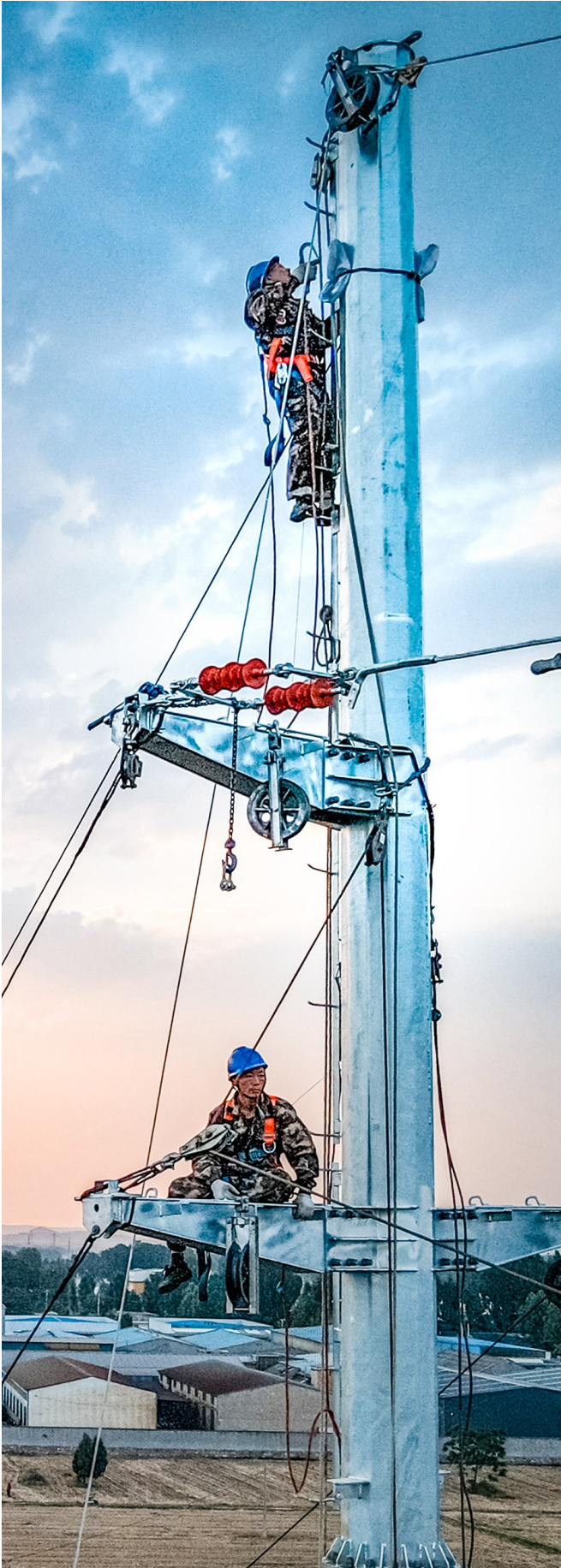
电力工人对线路进行导线展放。(曹欣 摄)
