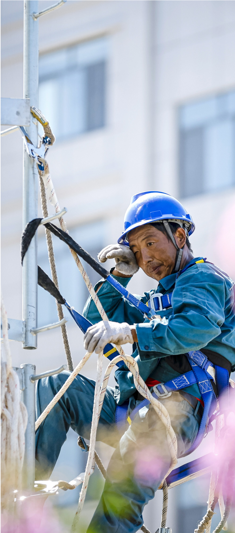
电力工人对线路进行导线展放。(曹欣 摄)
