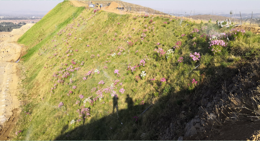
滕州市官桥东洪林村南破损山体生态修复
