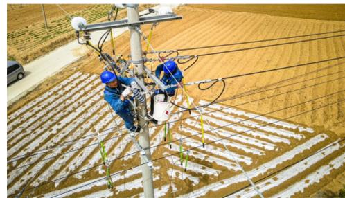
4月12日，在滕州市东郭镇，国网枣庄供电公司组织76名员工兵分4组，快速推进10千伏香台线检修进度，更换避雷引下线3处，安装跌落开关9组，调整横担6处等施工任务，提升线路安全运行水平，满足居民春季灌溉用电需求。(通讯员 曹欣 摄)
