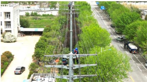
**高新区讯** “10千伏韩泰25、27浦东路I、II线站内电缆头试验、1至8号塔绝缘封包加装避雷线等综合检修任务已全部完成，现场17组临时接地线已全部拆除！”4月12日，随着国网枣庄供电公司高新供电中心配电运检班工作人员操作汇报结束，10千伏韩泰25、27浦东路I、II线综合检修工作圆满完成，进一步提升了该线路及设备应对强雷电天气防雷能力，为周边客户可靠用电添加了一道安全防线。
