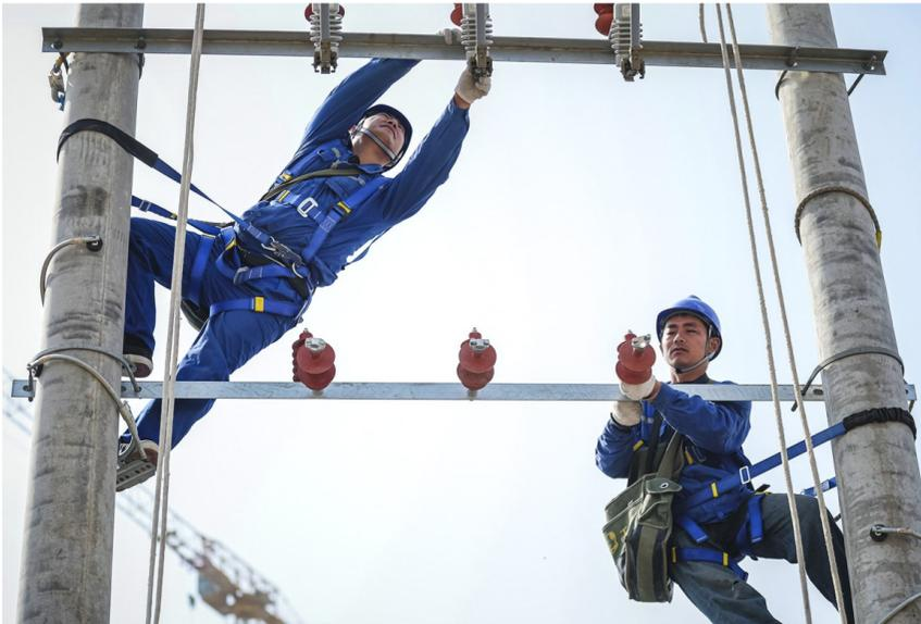
3月28日，国网枣庄供电鼎源公司组织施工人员对10千伏周村支线进行线路迁改，新立电杆2基、安装100千伏变压器一台。迁改完成后，将进一步提升线路供电能力，保障重点民生工程顺利施工。（通讯员 曹欣 摄）
